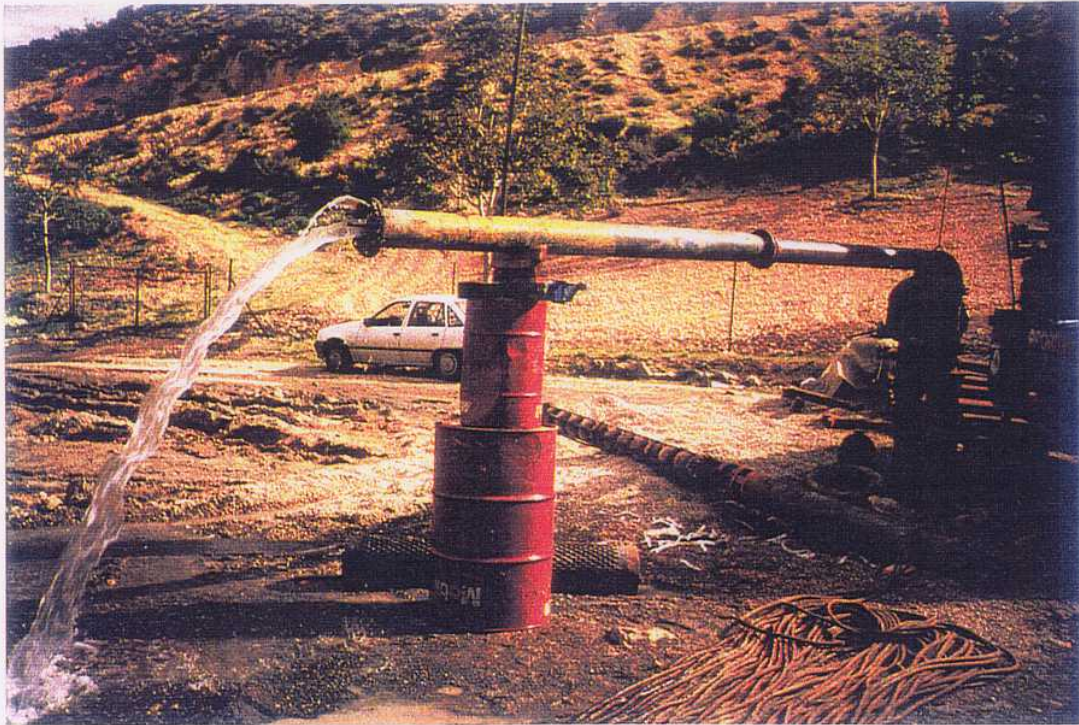
FOTO 15. Ensayo de bombeo escalonado del SONDEO ATASCADEROS. Segundo escalón con un caudal de 10 l/s. Santiago-Pontones (Jaén).
