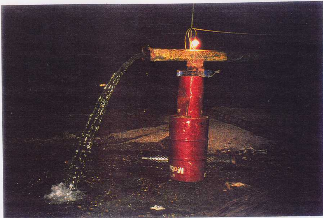
FOTO 17. Primer ensayo de bombeo a caudal constante de 7 l/s del SONDEO ATASCADEROS. Santiago-Pontones (Jaén).
