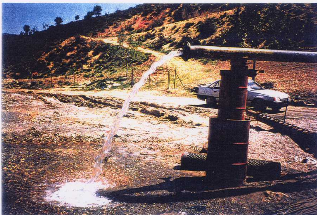
FOTO 14. Ensayo de bombeo escalonado del SONDEO ATASCADEROS. Primer escalón con un caudal de 5 l/s. Santiago-Pontones (Jaén).
