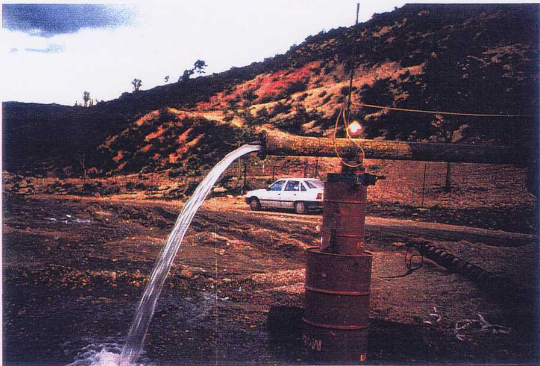
FOTO 16. Ensayo de bombeo escalonado del SONDEO ATASCADEROS. Tercer escalón con un caudal de 15 l/s. Santiago-Pontones (Jaén).
