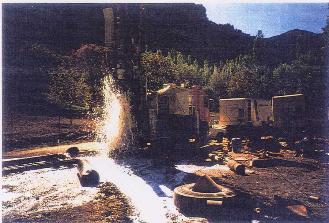
FOTO 3. Labores de perforación a rotopercusión durante la investigación. Profundidad de 84 m con un caudal de 5 ó 6 l/s. SONDEO ATASCADEROS.
