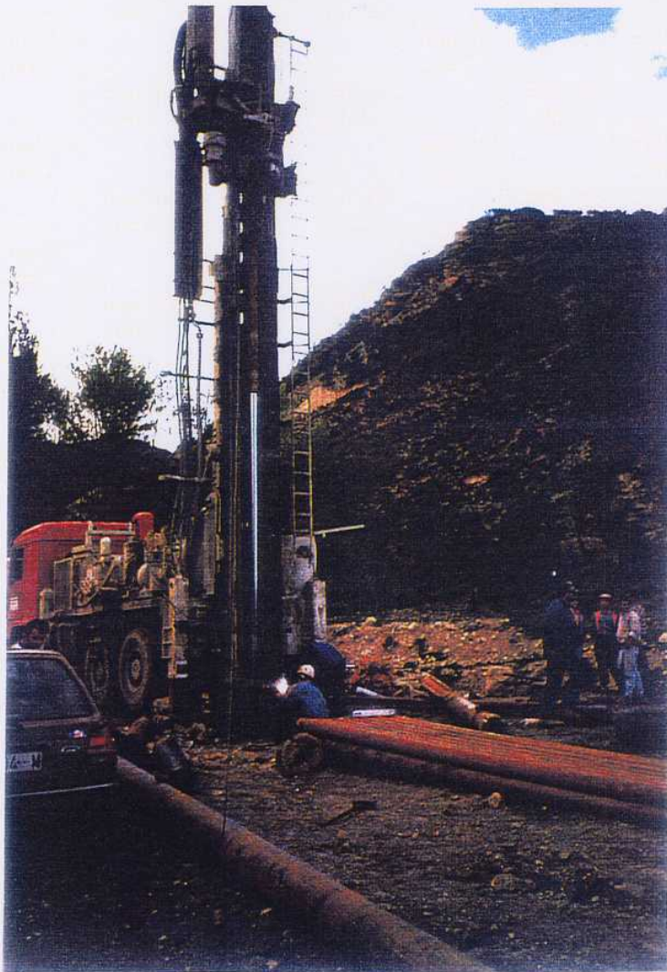
FOTO 5. Labores de empalme de las tuberías de filtro de puentecillo con soldadura electrógena. SONDEO ATASCADEROS (Santiago-Pontones, (Jaén).
