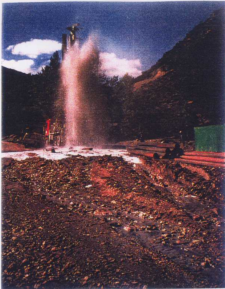
FOTO 9. Entubación de los metros finales del SONDEO ATASCADEROS. Hubo que trabajar con grandes presiones de aire y empujando la cabeza rotatoria, lo que provocó el levantamiento de grandes columnas de agua.
