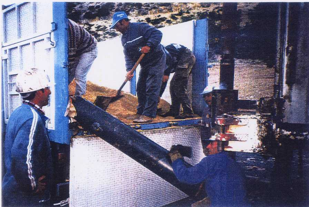
FOTO 10. Labores de engravillado síliceo del cilindro anular entre la tubería y las paredes del SONDEO ATASCADEROS (Santiago-Pontones, Jaén).
