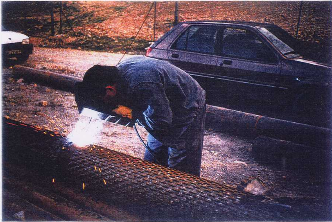
FOTO 5. Labores de empalme de las tuberías de filtro de puentecillo con soldadura electrógena. SONDEO ATASCADEROS (Santiago-Pontones, (Jaén).
